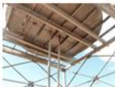
Problème d'étanchéité : château et réseau
