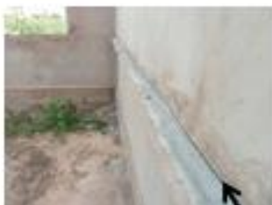
Pose craie désolidarisé du mur
