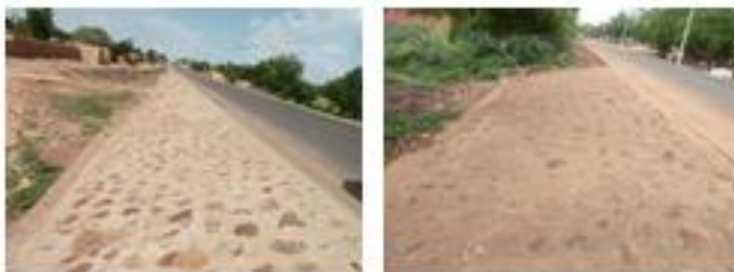
Protection en perré maçonné à Toudoun Agoua
