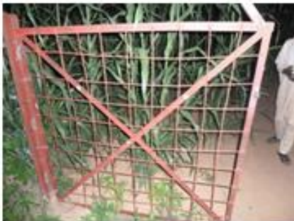
Porte d'entrée travaux
