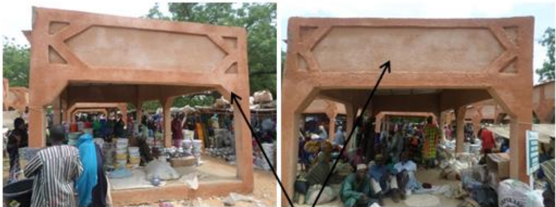
Teinte des enduits tyroliens non uniforme
