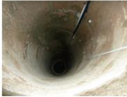
Puits maraicher muni de pompe immergée
