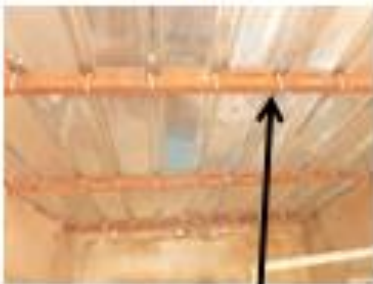
Tube carré sans peinture ni feutre bitumé
