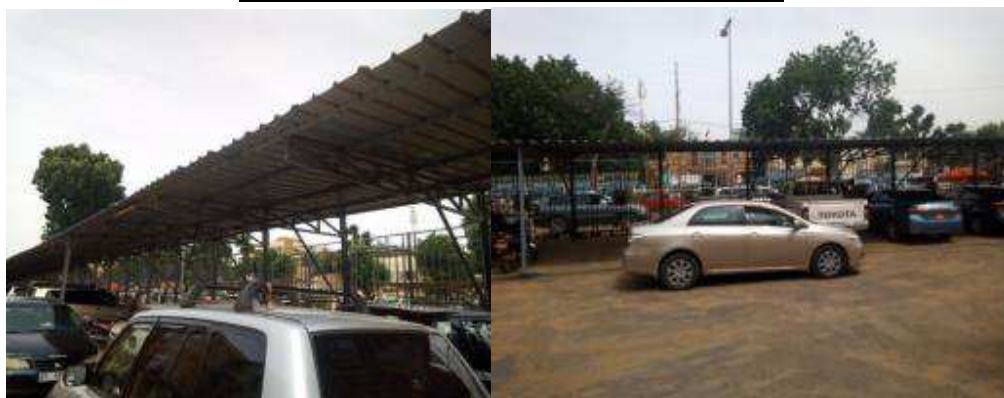
Photographies des ouvrages réalisées.
