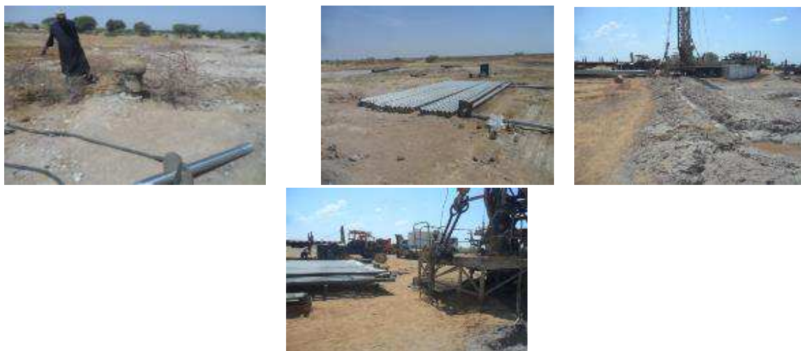
Photographies des ouvrages réalisées.
