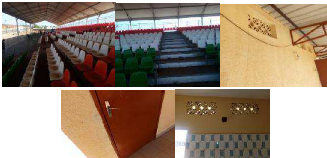
Photographies des ouvrages réalisées.
