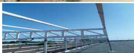
Vue Générale des travaux
