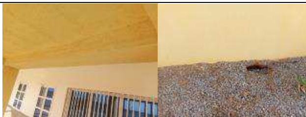
Photographies des ouvrages réalisées.
