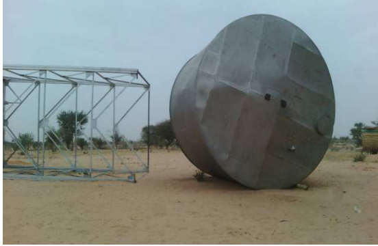
Réservoir (100m 3 ) posé au sol sur la fondation du château
